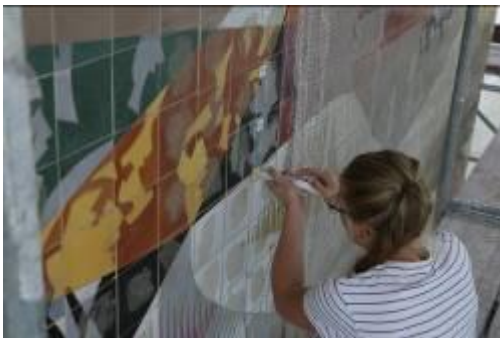
Festigung von Fliesen durch Injektionen, Foto: Gustav van Treeck GmbH
