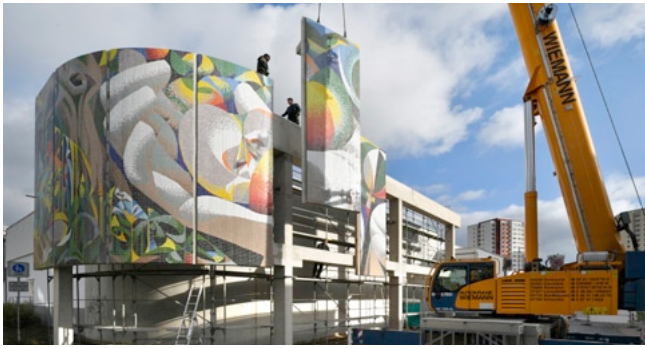
Einhängen und Ausrichten der Elemente in die Stahlbetonkonstruktion, Oktober 2019
