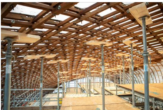
Multihalle Mannheim: Schwerlastsprieße drücken die Holzkonstruktion an einer Probefläche in ihre ursprüngliche Geometrie. Foto: Arthur Bauer / Wüstenrot Stiftung
