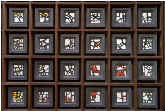
Kapelle der Kaiser-Wilhelm-Gedächtniskirche: Holzraster auf der Innenseite der Betonglaswand. Foto: Thomas Wolf / Wüstenrot Stiftung
