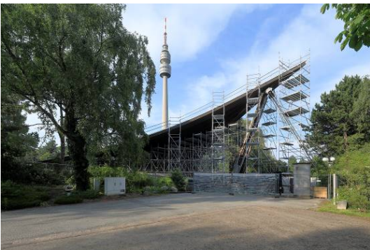
Sonnensegel Dortmund: Ansicht Sonnensegel mit Baugerüst. Foto: Hans Jürgen Landes / Wüstenrot Stiftung
