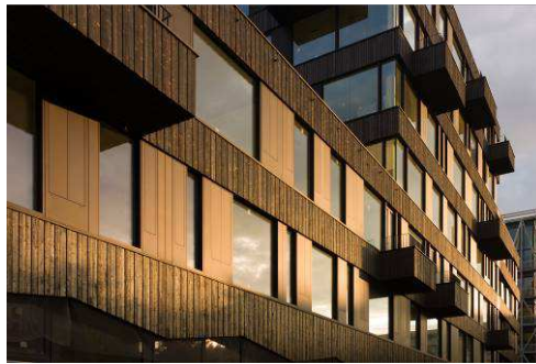
02_Deutscher Städtebaupreis 2020. Quartier am ehemaligen Blumengroßmarkt Berlin. FRIZZ 23, Fassade zum Besselpark. Foto: Matthew Griffin
